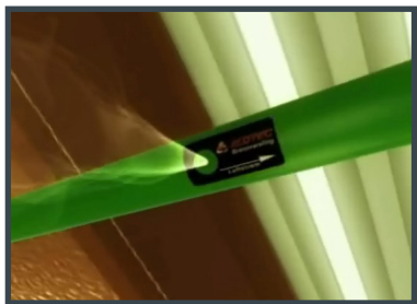
Luft sugas genom borrade hål i rörsystemet som löper genom hela huset
